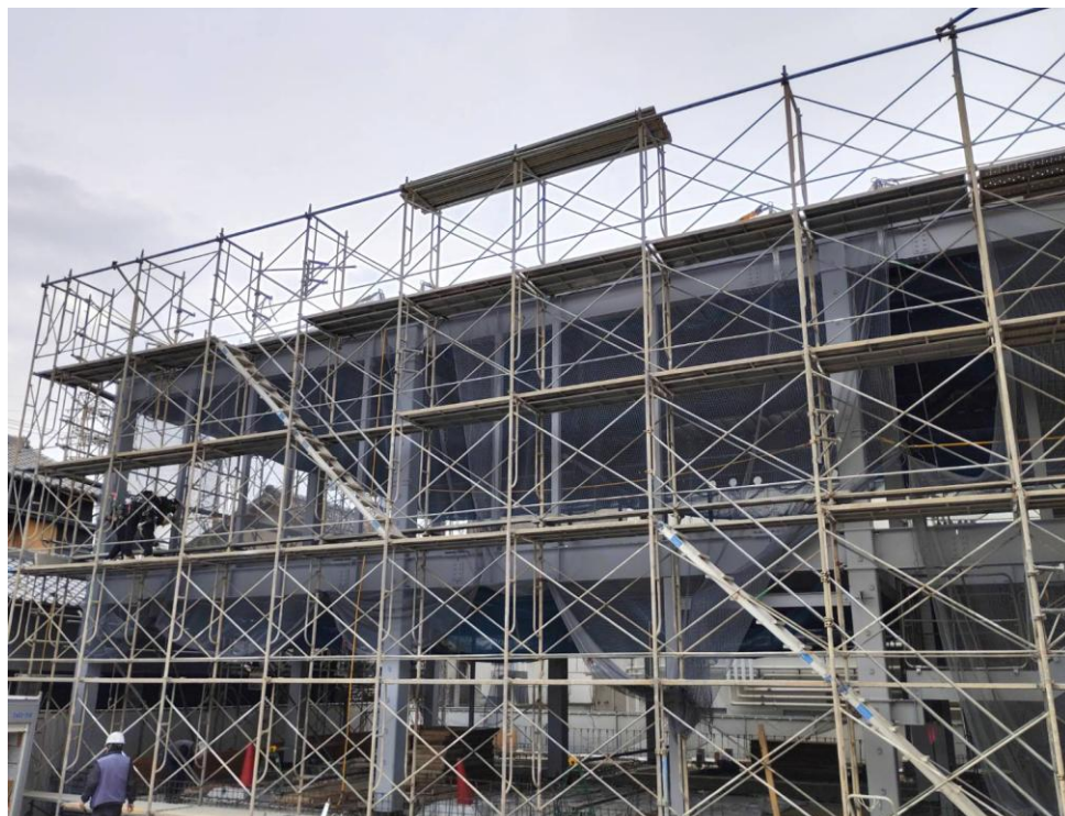
現場は慌ただしく躯体工事が行われていました！(2026.3.18撮影)
